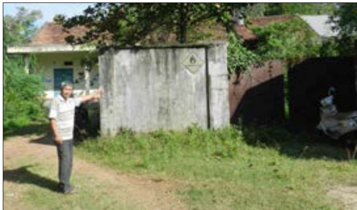
▲ Khu vực kho thuốc BVTV núi Voi, thị trấn La Hà, huyện Tư Nghĩa, tỉnh Quảng Ngãi có mức độ ô nhiễm vượt quy chuẩn cần được xử lý
