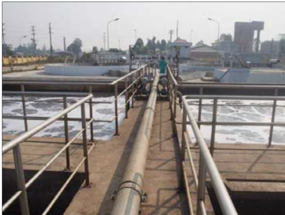
▲ Nhà máy xử lý nước thải xã Quất Lưu, huyện Bình Xuyên, tỉnh Vĩnh Phúc
